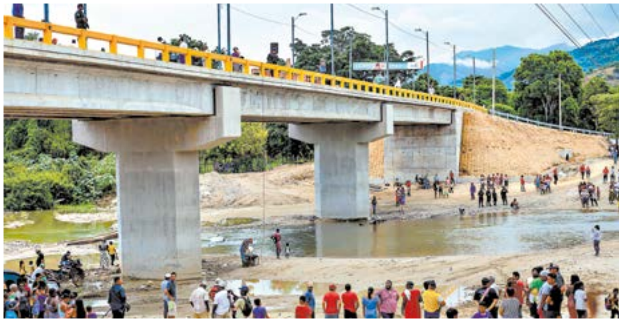
El puente tiene una longitud de 120 metros de largo y se destaca por tener 8.20 metros y dos carriles de circulación.
