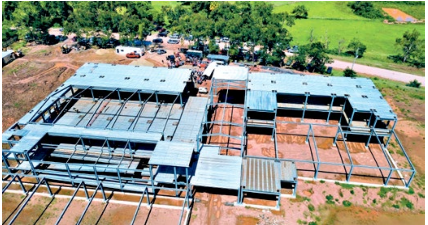
La construcción del hospital de Salamá será culminada en septiembre de 2025.
