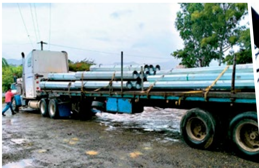
Desde San Pedro Sula, Cortés, se dirigieron acciones en campo de la ENEE; ENEE-Distribución y PNRP, en atención a múltiples y severas fallas en la red de distribución en el departamento y zonas aledañas.
