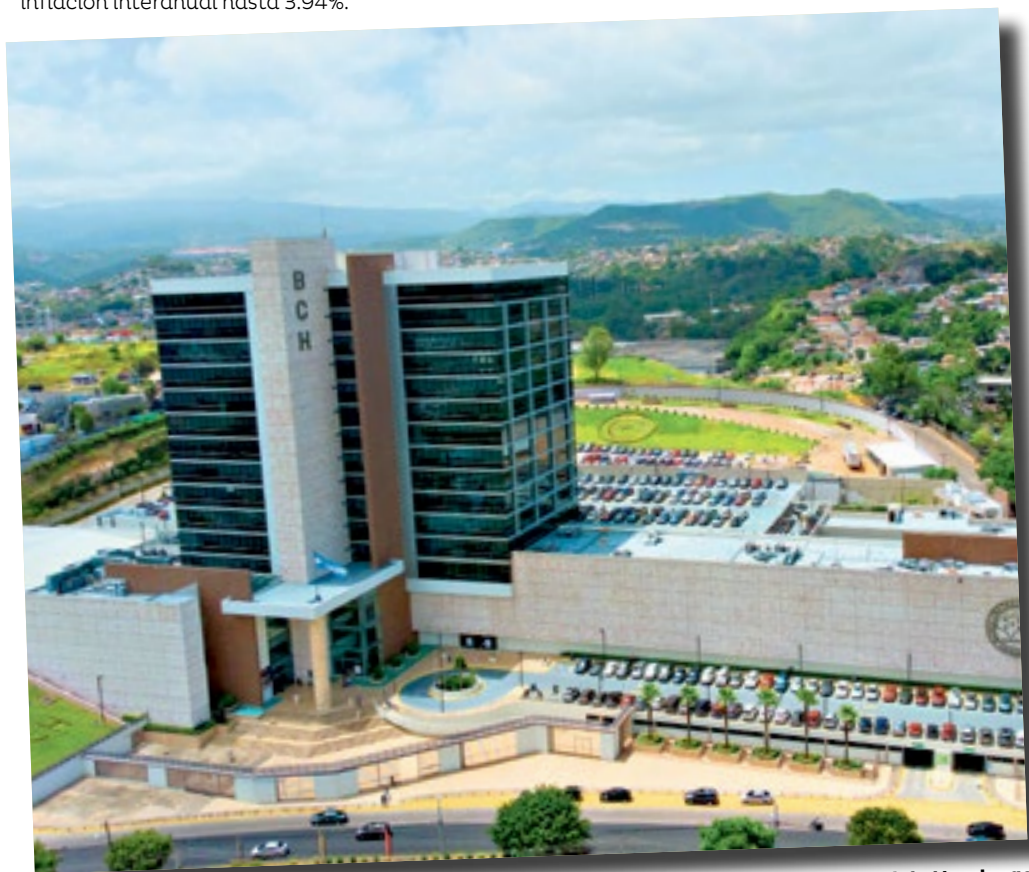
Instalaciones del Banco Central de Honduras.
