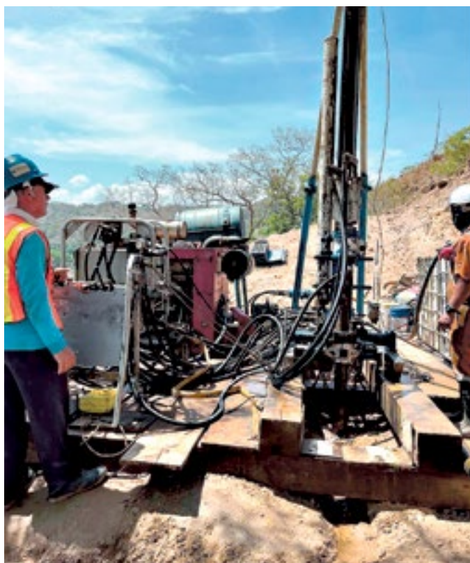
Las obras de construcción de la presa "El Tablón" darán inicio en el mes de octubre, trayendo múltiples beneficios al Valle de Sula.
