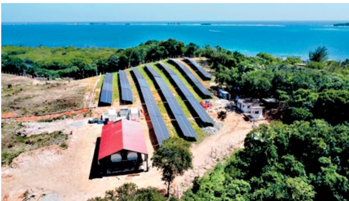
Instalaciones del Proyecto PERLA, de energía eléctrica base de paneles solares en Guanaja.
