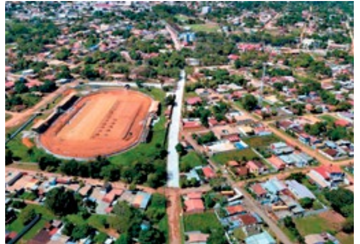
Se pavimenta con concreto hidráulico la calle de acceso al estadio "Rubén Guifarro", en la colonia La Hoya, de Catacamas, Olancho.
