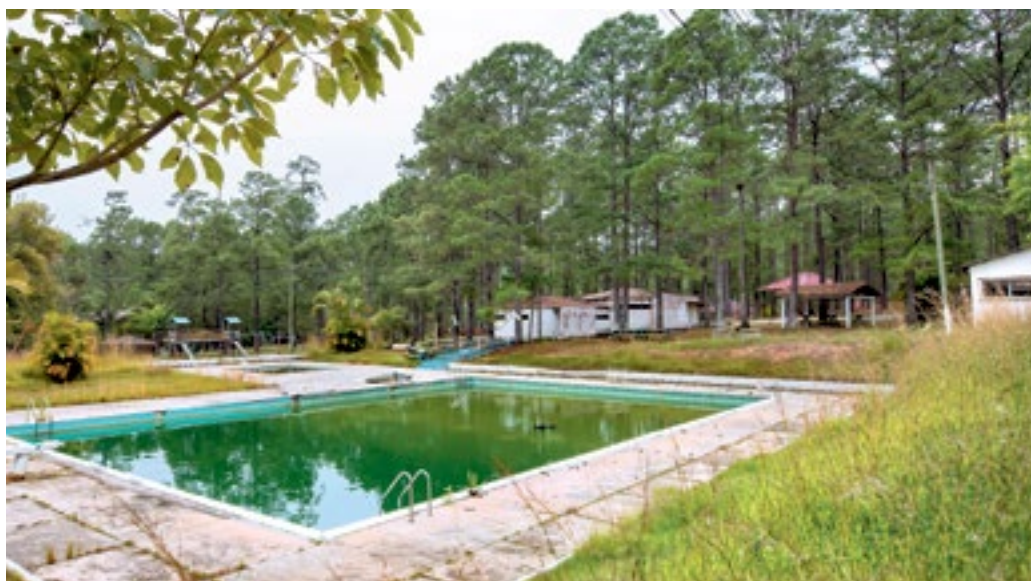
Entre las remodelaciones destaca la piscina, que incluye la reparación de paredes, pintura, nivelación a una profundidad de dos metros y la instalación de un nuevo sistema de bombeo y filtrado de agua.
