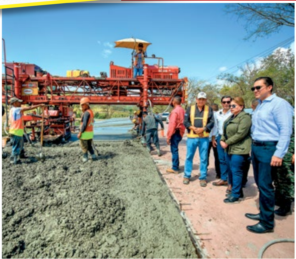
La Presidenta Xiomara Castro, junto al Secretario Privado, Héctor Zelaya y el titular de la SIT, Octavio Pineda, inspeccionó los avances en la construcción del tramo carretero Cantarranas-Talanga.
