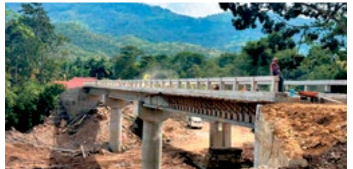
La construcción del puente sobre el río Chamelecón, en Nueva Arcadia, Copán, a pocos metros de la CA-4, prácticamente se ha concluido.
