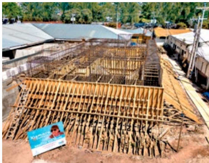
La construcción del Bunker Oncológico estará finalizada para el mes de junio del presente año.
