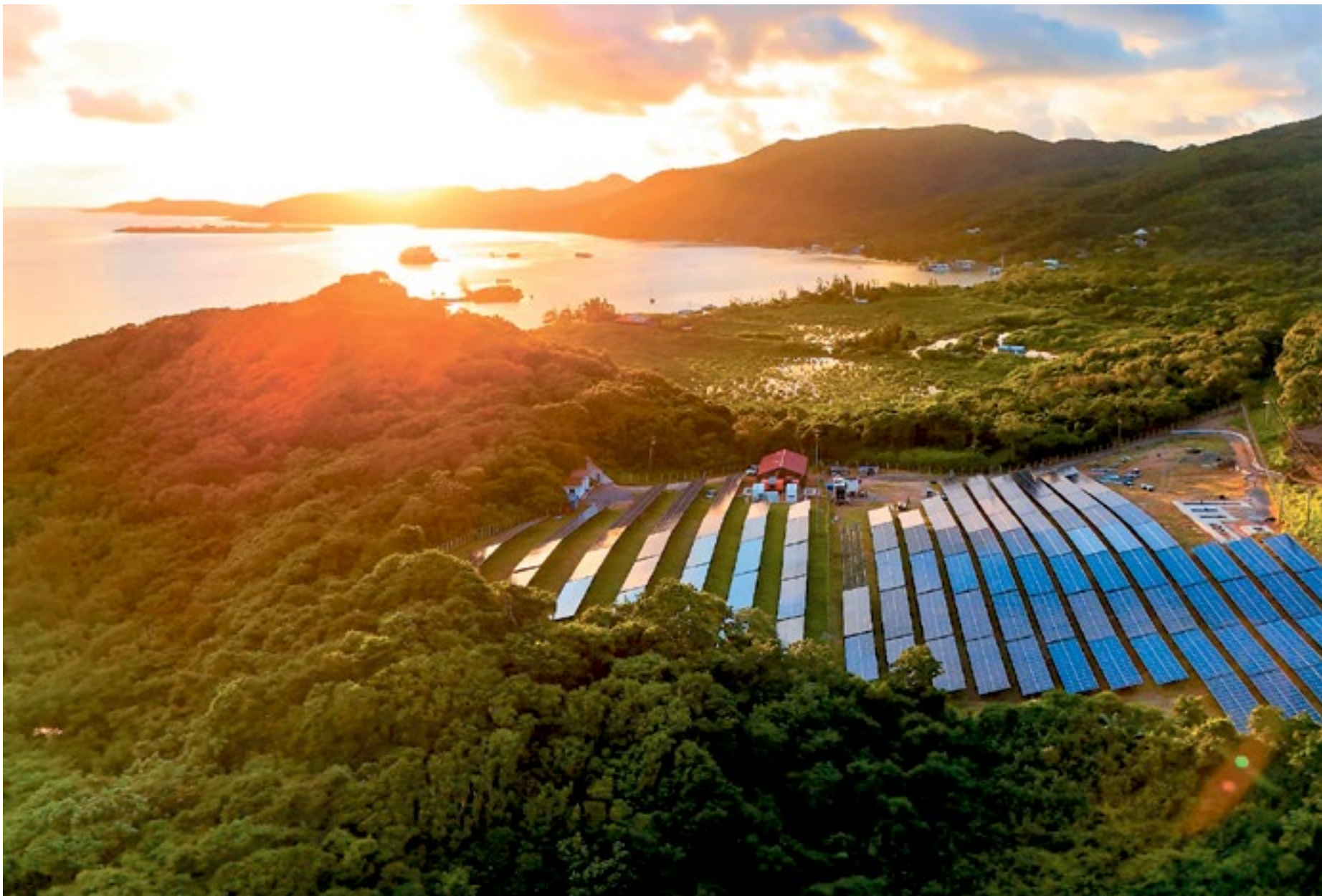
Instalaciones del proyecto energético con paneles solares denominado "Isla de Energía Verde", y ubicado en Guanaja, Islas de la Bahía.
