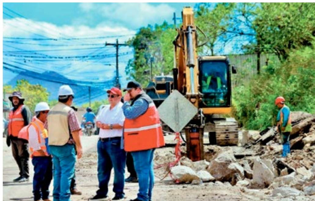
El alcalde del Distrito Central, Jorge Aldana reveló que ejecutando 1.5 kilómetros de tubería y se construirá la calle nueva con concreto hidráulico.
