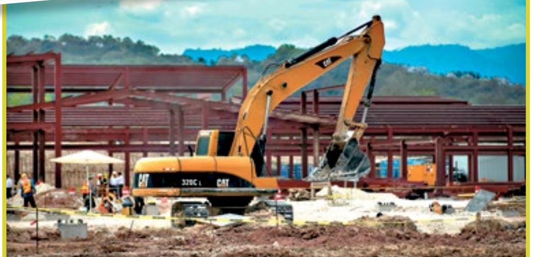
El personal de la empresa encargada de la edificación trabaja sin descanso para cumplir con el tiempo estipulado.
