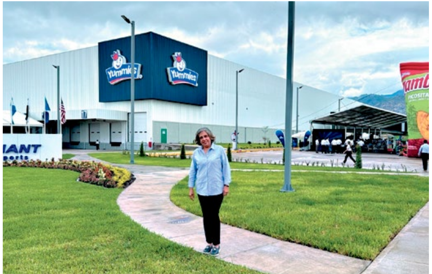
La nueva planta industrial de la empresa Dinant, generará 1,200 empleos directos y 4,800 indirectamente en la región central del país.
